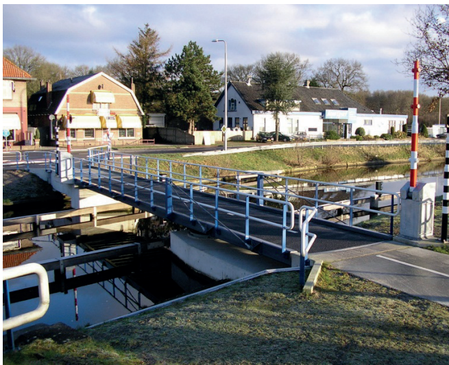
Bilde 1-1. Eksempel på bruk av bom. (type RhS)
