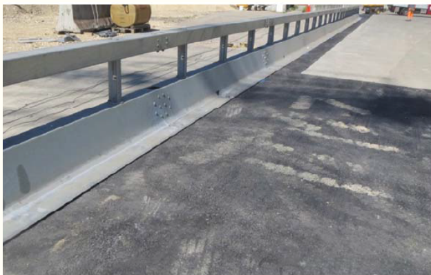
Underlag: VarioGuard er testet plassert på asfalt.
