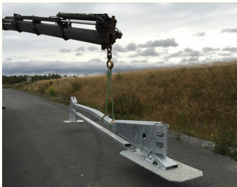
SE-VG kobling med QJ-hurtigkobling til VarioGuard
