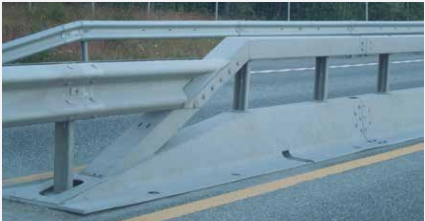
Midtdeler; tosidig overgang VG-W rekkverk
