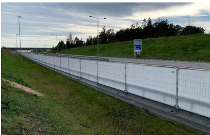
Anleggsgjerde med plastduk
