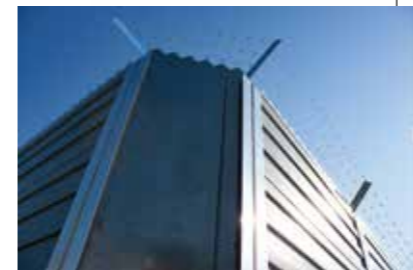
SafeSound utstyrt med klatresikring.
